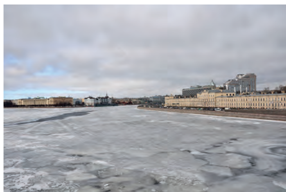
Искажение и утрата целостности охраняемых историко-культурных панорам Санкт-Петербурга после возведения ЖК «Монблан». Вид с Литейного моста.
