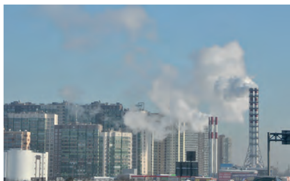
Котельные микрорайона «Мурино».
