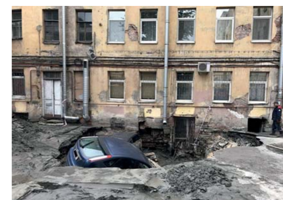
Промоина в асфальте из-за прорыва магистральной трубы отопления у кафе «Типичный Питер» (Измайловский пр., д. 20).
