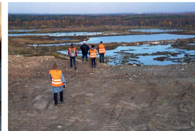
Вид на полигон по складированию осадка сточных вод «Северный» (ГУП «Водоканал Санкт-Петербурга»). 16.10.2018.
