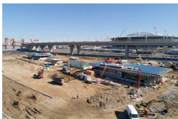
Строительство станции метро «Новокрестовская». Фото с сайта metrostroy-spb.ru.
